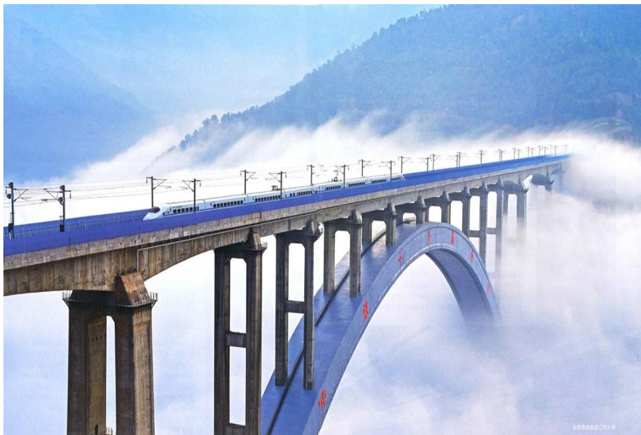
云桂铁路南盘江特大桥
