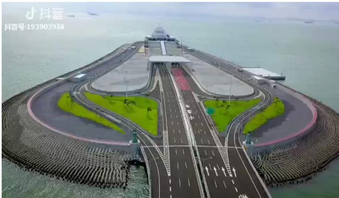
港珠澳大桥拱北隧道
